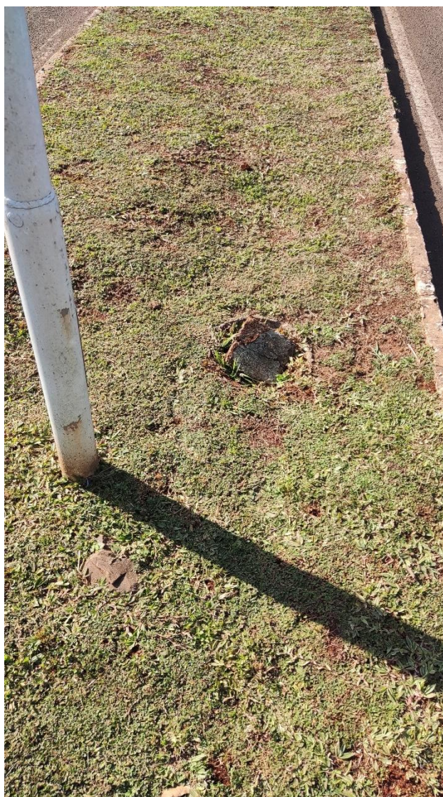
Figura 1. Tubo de passagem a ser modificado.
