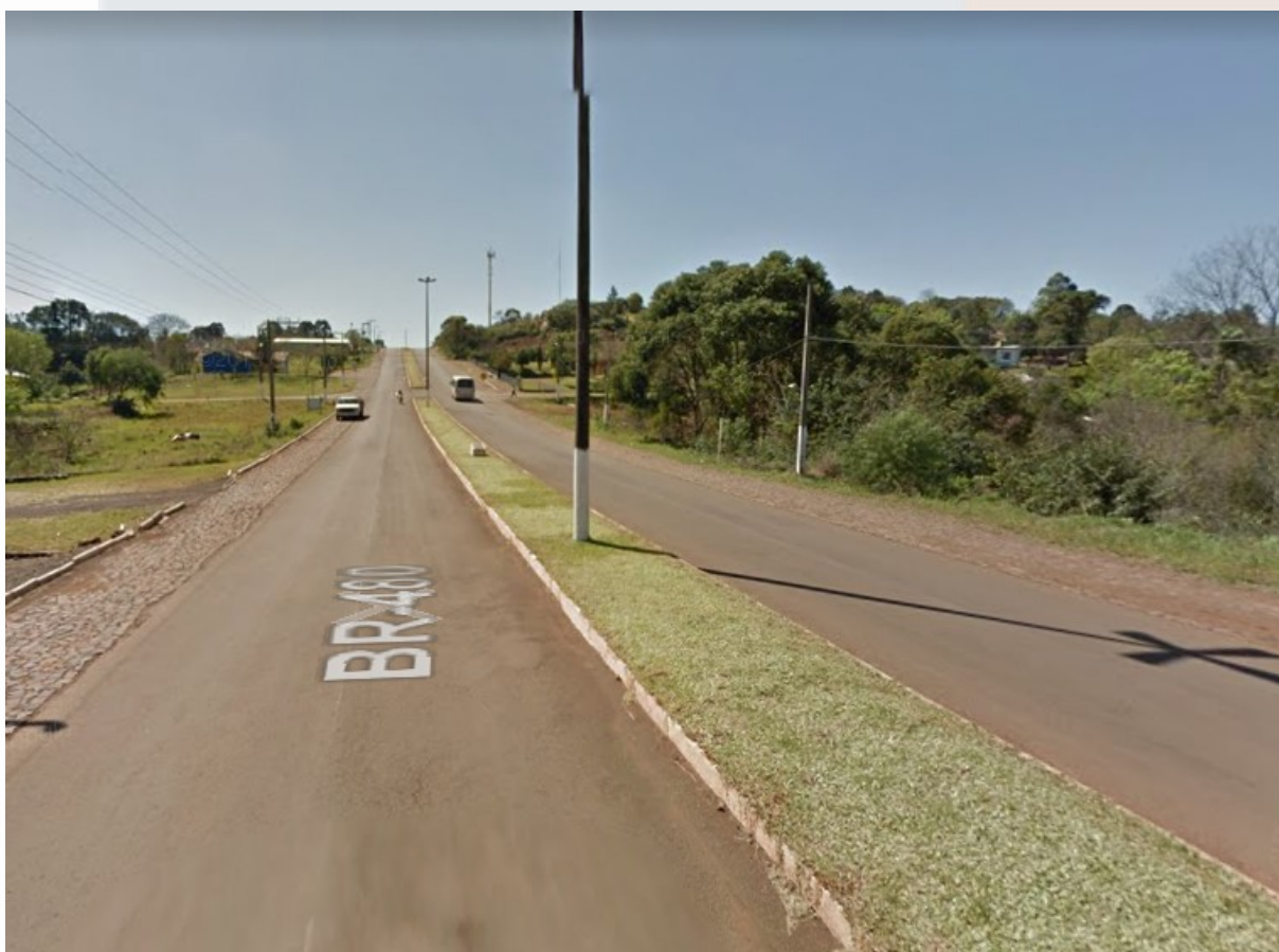
Figura 02– Detalhe do canteiro central para remoção do meio fio existente.
