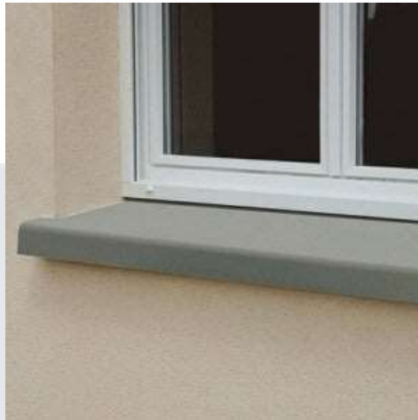
Figura 1- Peitoril embutido 1 cm na alvenaria
