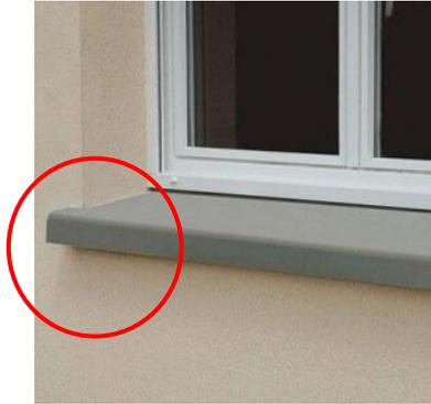
Figura 2- Peitoril embutido 1 cm na alvenaria
