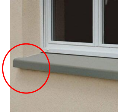
Figura 2- Peitoril embutido 1 cm na alvenaria
